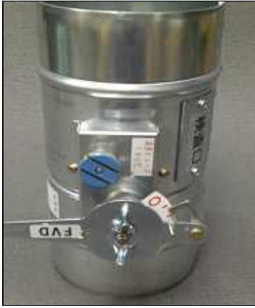
ヒューズが落ちた状態です
